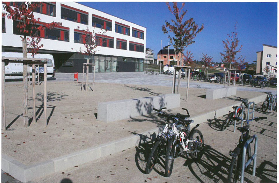
4 Schule in Lappersdorf: Hauptzugangsplatz mit Plattenbelag (hinten), seitliche Baumplätze unversiegelt (hier: Stabilizer beige)
