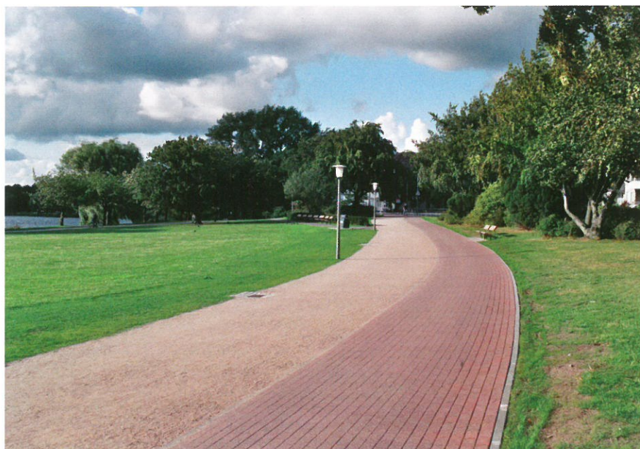
1 Intelligente Lösung am stark befahrenen Außenalsterweg in Hamburg: ein Teil versiegelt, ein Teil wassergebunden (hier: HanseGrand Original)
