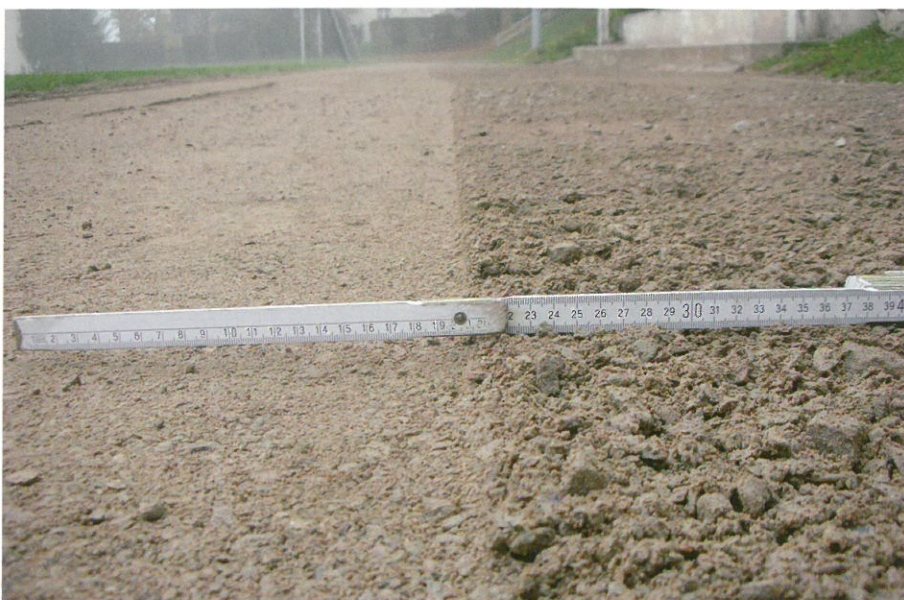
2 Die dynamische Schicht (rechts unverdichtet) optimiert die Funktion der Decke. (hier: HanseMineral)
