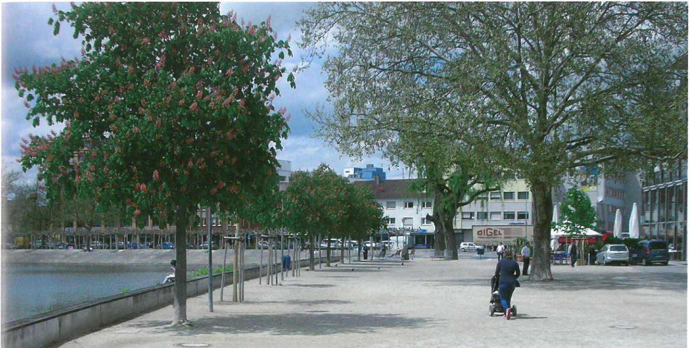
8 Beispiel Elbenplatz Böblingen: Sanierung mit guter Körnung, doch punktuell etwas zu schwachem Quergefälle
