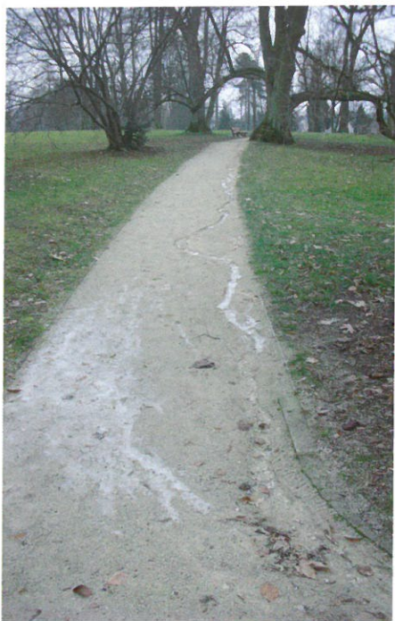
6 Häufiges Schadensbild bei geneigten Wegen und inkonsequenter Entwässerung
